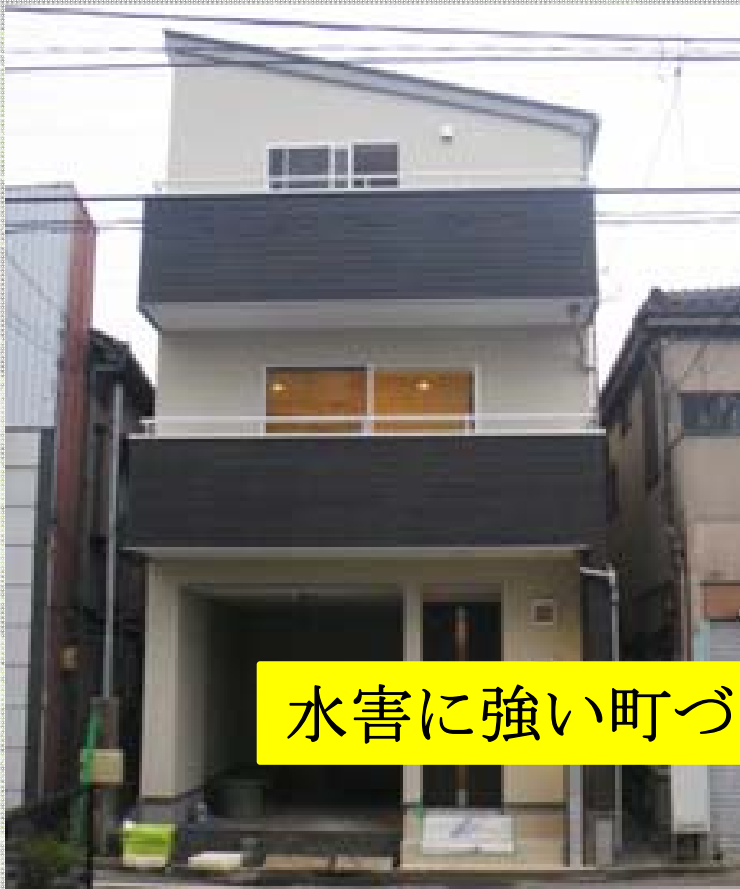
1階を駐車場にした家屋 (アイフルホームHPより)
