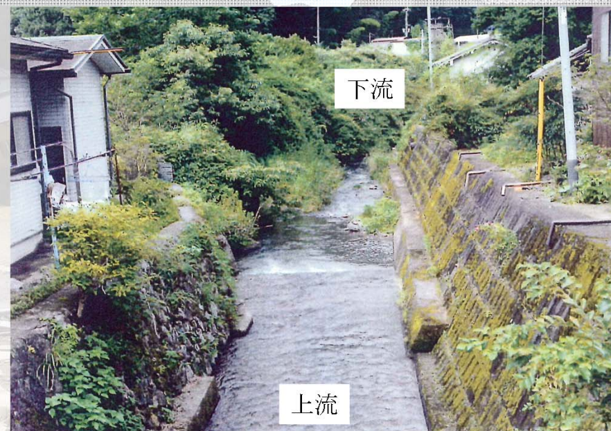
(b) 被災前の前川橋下流の様子
