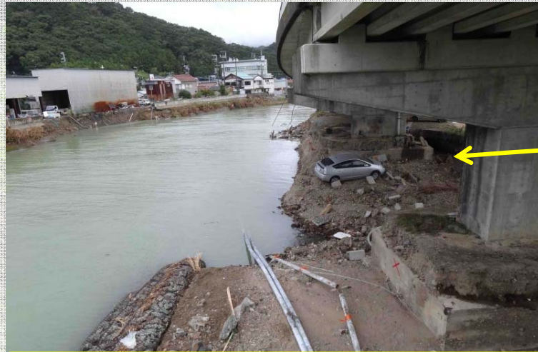
(d) 河岸浸食により破壊された護岸
