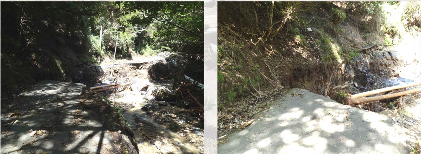
(b) 喜撰山ダムへ通じる道路の破壊
