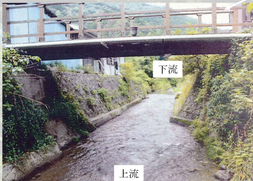
(a) 被災前の前川橋
