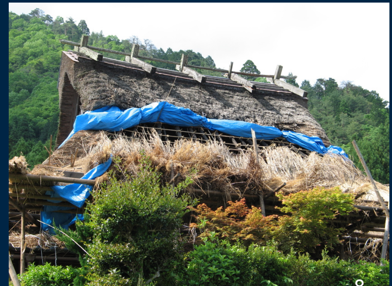
京都府美山町北集落の茅葺き屋根吹き替え
