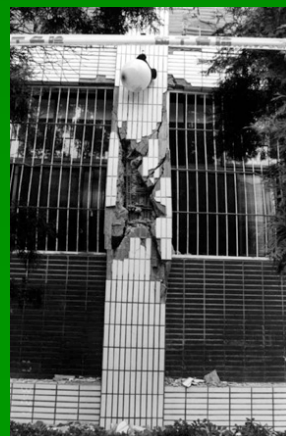
破壊した柱
