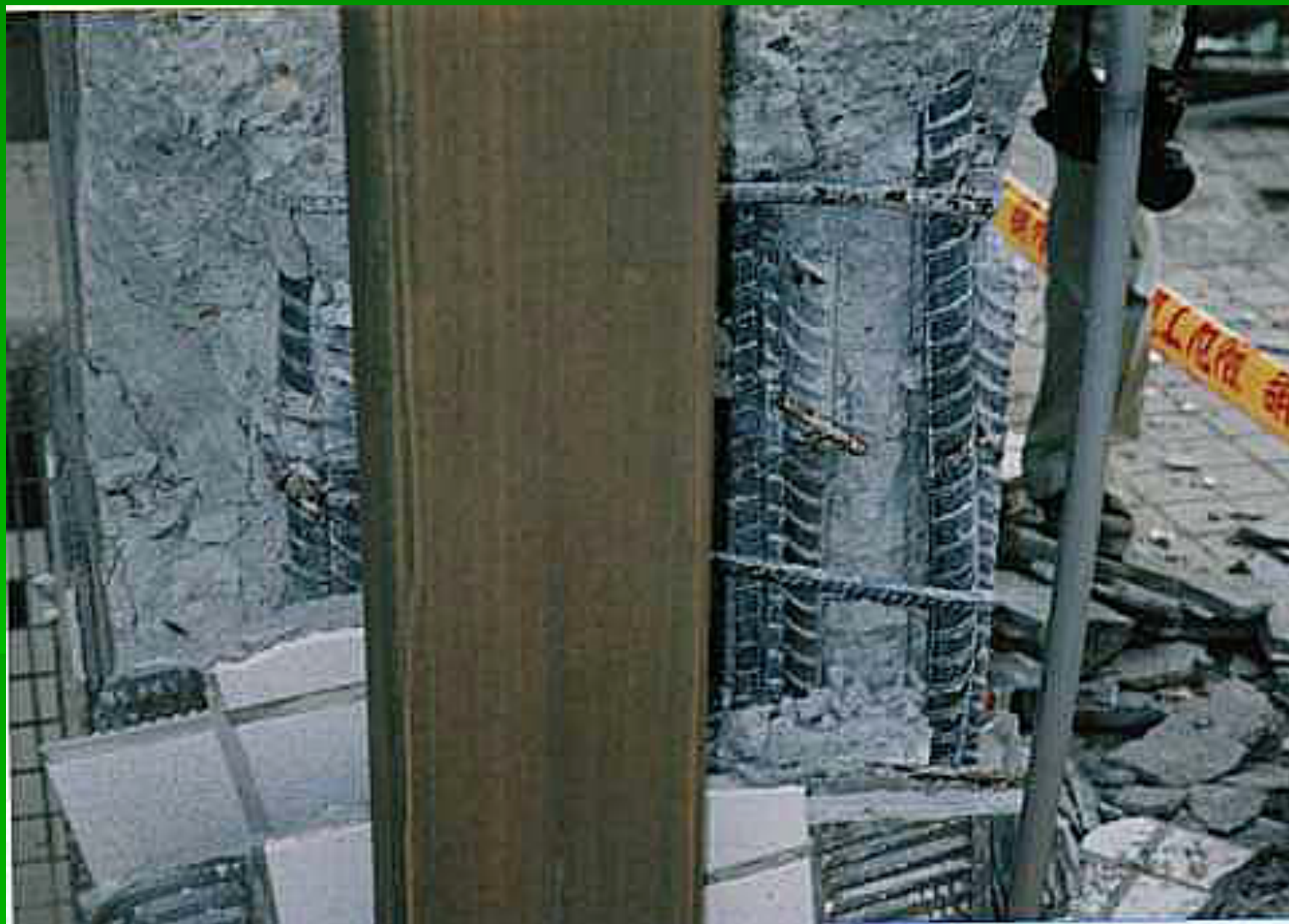
大里(配筋位置のずれ)
