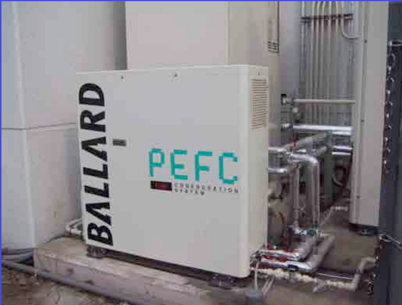
荏原バラード製 固体高分子形燃料電池コージェネレーション (燃料電池ユニット)
