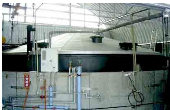
この装置は 100 頭の牛の糞をメタンガスとして採って、発電する装置です。なかなか、商売になるほど、電力回収ができない悩みを持っています。しかし、肥料としても使っていますし、電力だけではなくいろいろな用途に使えるというメリットで、農村向きのいい装置だと思います。これは、下水処理場から出たメタンで、250kW の燃料電池を運転している装置です。都市の電力消費のおよそ 0.7% が下水処理場で使用されているというように、非常に大きな動力を下水処理場で使用しています。例えば、人口が 60 万人の下水処理場。これは、電力を 4,600kW 使った下水処理場で処理されています。そして、下水汚泥が毎日 300t 出てきます。この 300t は、埋め立てるか処理しなければならないわけですが、これは、明らかにバイオマスでして、エネルギーとして回収しようではないかという実験を、昨今行っています。60 万人の都市の下水処理場で使われる 4,600kW の電力。これを自分が出す汚泥で処理できるかということですが、汚泥の
