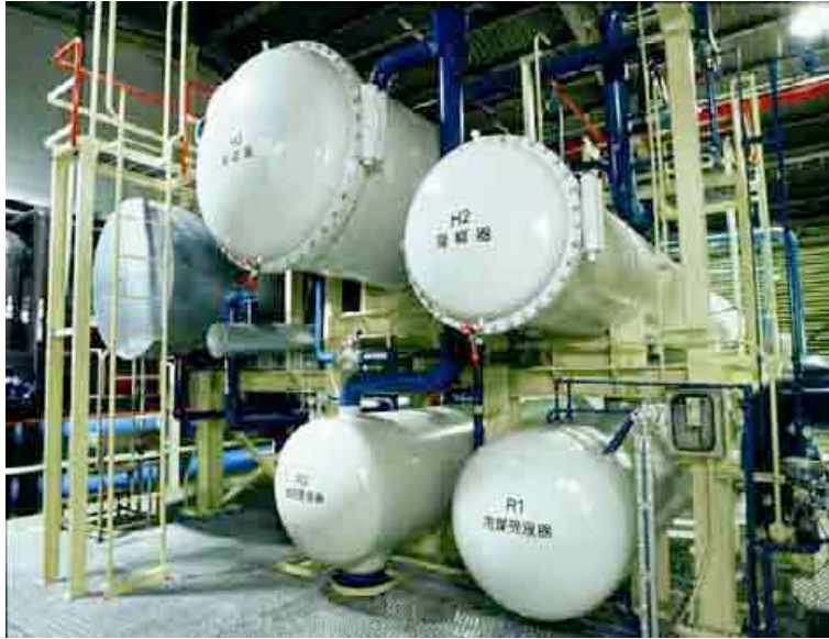
名古屋工場アンモニア吸収式冷凍機
