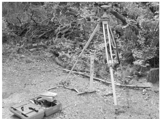
写真 3.2 GPS 測量による基準点の設置
